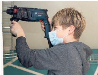
Julius fixiert einen Kabelkanal an der Wand.
