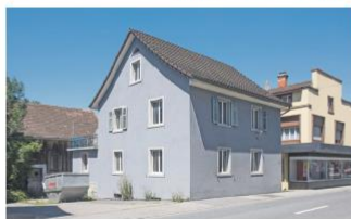
Das teilautonome Haus an der Landstrasse 64 in Schaan. (Foto: Michael Zanghellini)
